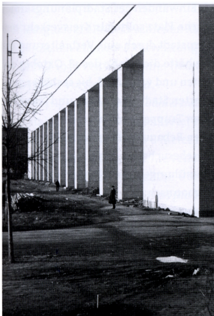
Kopfbau der Halle 11, Februar 1938
